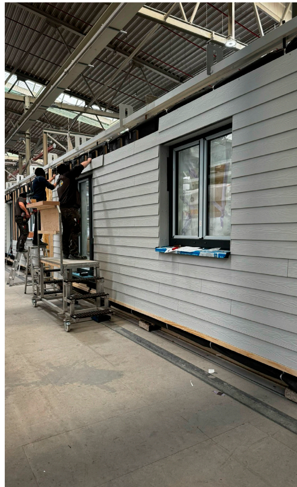
Elemento de fachada para reforma em série na pré-fabricação
