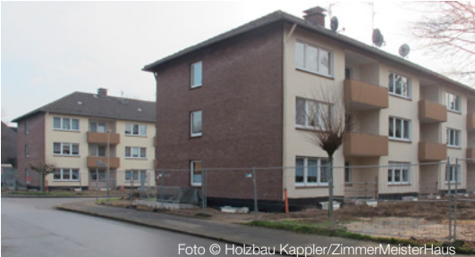
Foto © Holzbau Kappler/ZimmerMeisterHaus
