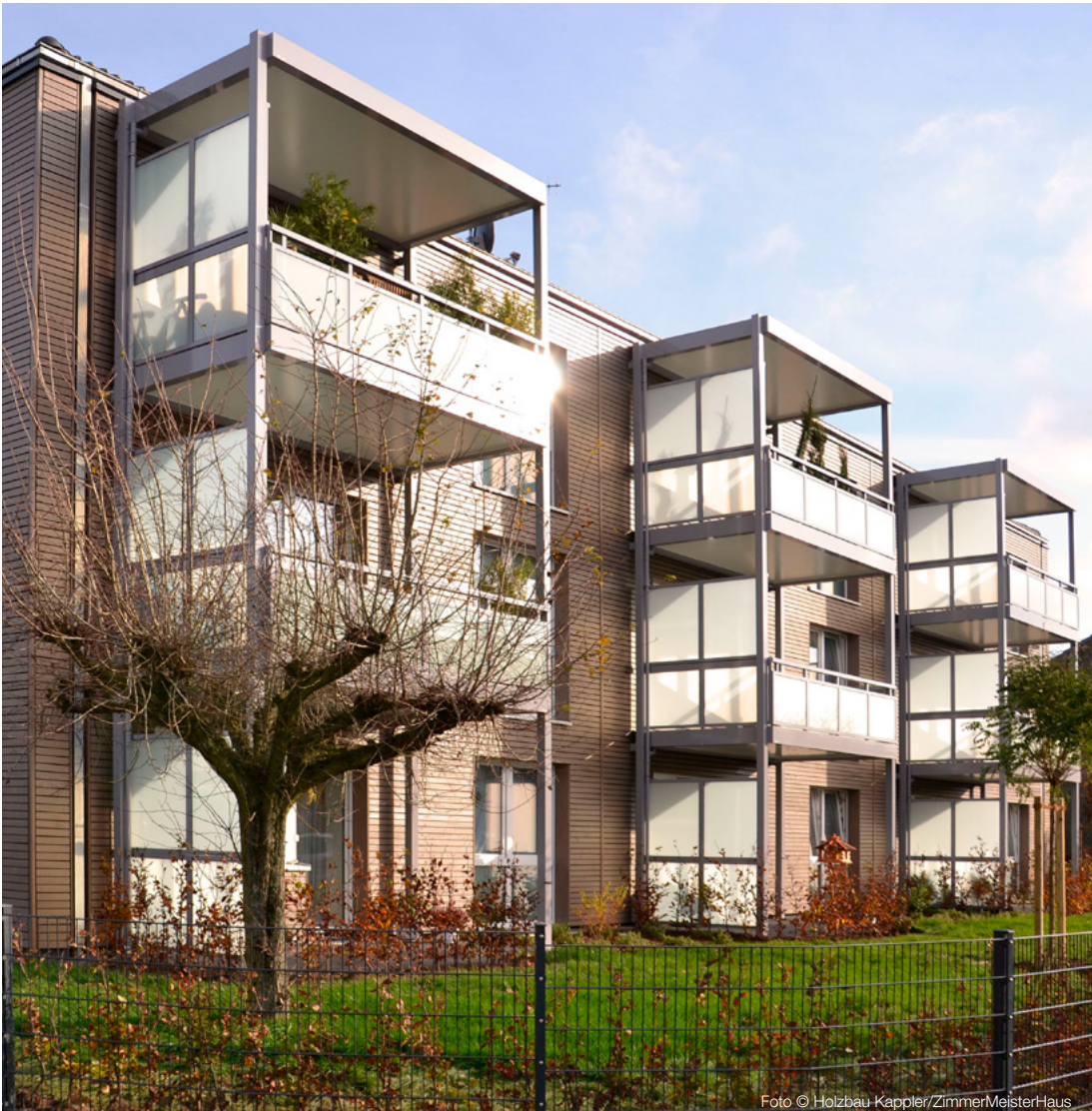
Foto © Holzbau Kappler/ZimmerMeisterHaus
