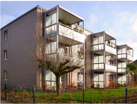
Fotos: Eficiência em cada detalhe: a granIT o guia através do processo de fabricação da sua construção de estruturas de madeira, com controle e uma estrutura clara.
