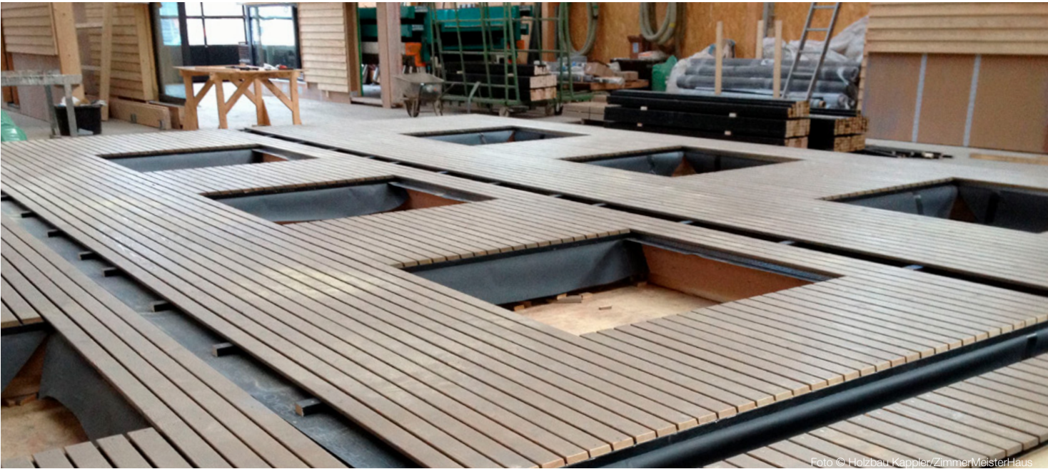
Foto © Holzbau Kappler/ZimmerMeisterHaus
