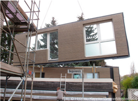
Foto © Holzbau Kappler/ZimmerMeisterHaus
