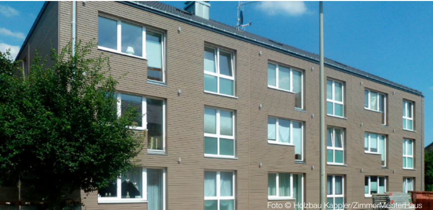
Foto © Holzbau Kappler/ZimmerMeisterHaus
