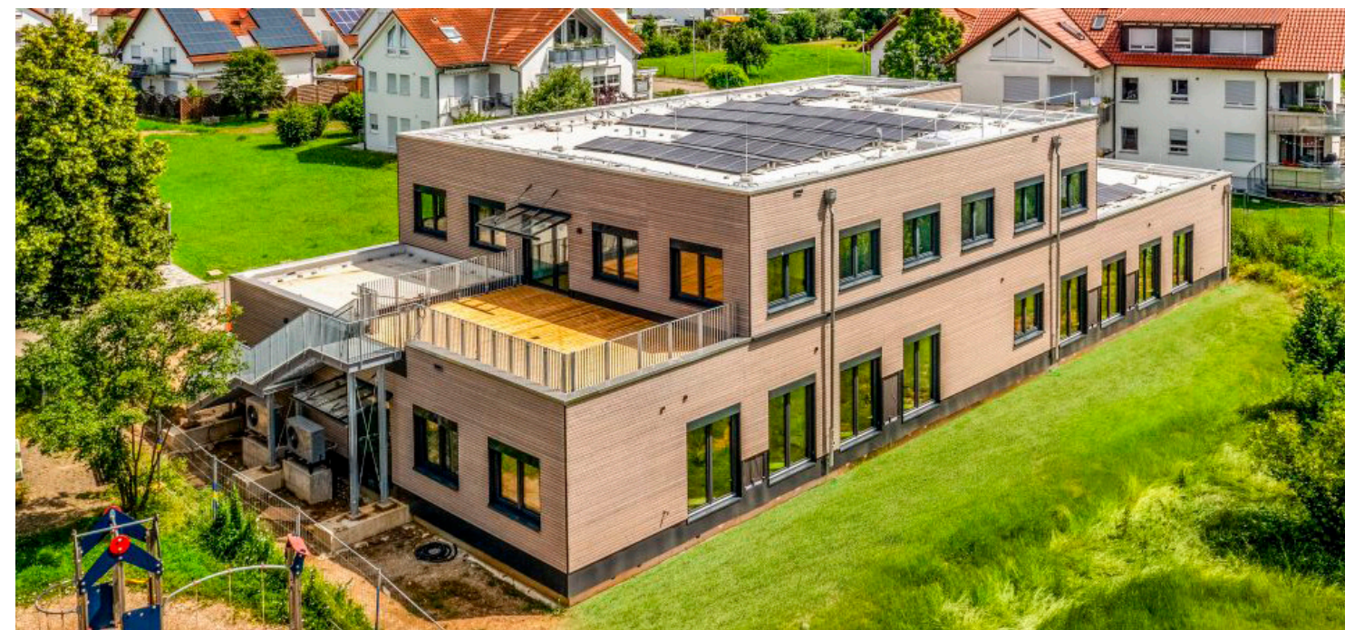
La crèche de Wittum 1 à Reutlingen, construite avec des modules en bois
