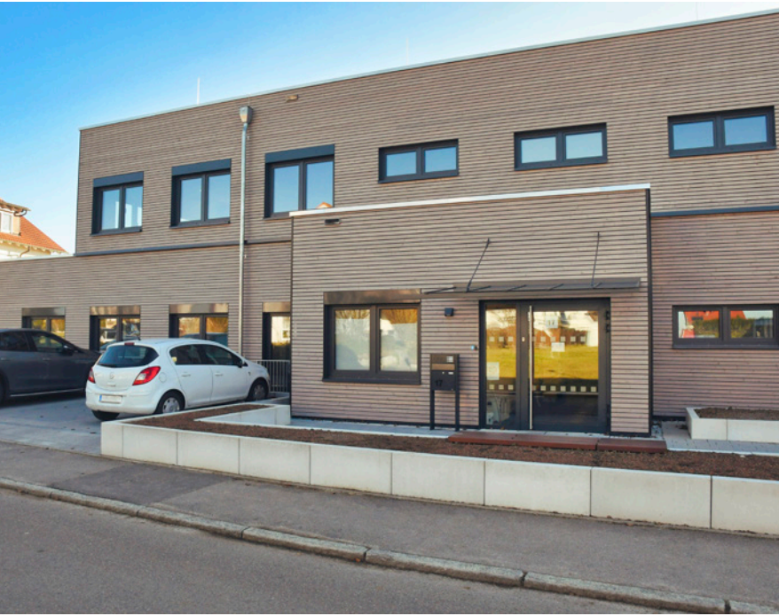
La crèche de Wittum 1 à Reutlingen, construite avec des modules en bois
