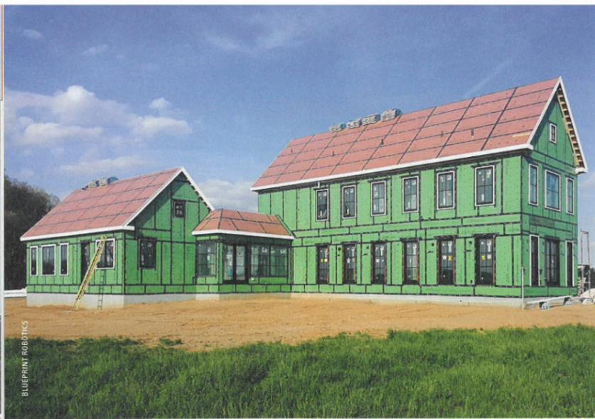
◀ Blueprint Robotics liefert meist wasser-dichte Rohbauten. Fassade und Innenausbau sind Sache der gewerblichen Bauherren
