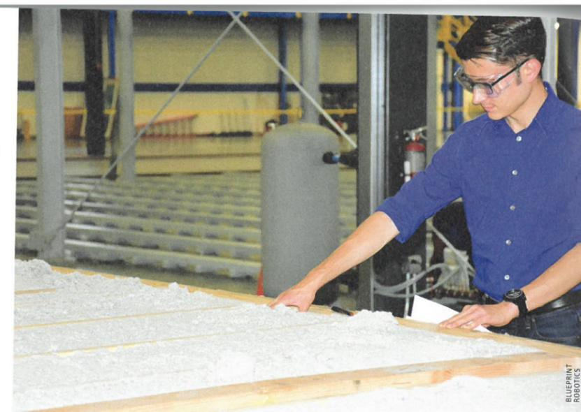
▶ Sichtkontrolle nach Einblasen des Dämmstoffs mit der Weinmann WMS 150 blowTEC
