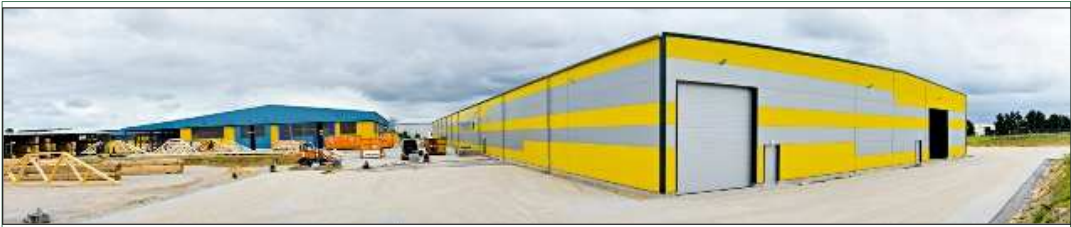
Rechts die Produktionshalle 5 mit dem 2000 m²-Anbau (vordere zwei Segmente) Foto: Schnoor
