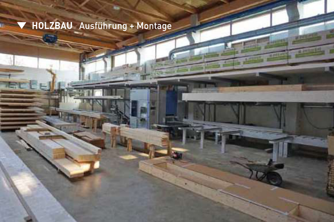
Blick in die Abbundhalle der Firma Roßner mit der Abbundanlage „BE-AMTEQ B-660“ von Weinmann Foto: Zimmerei Roßner
