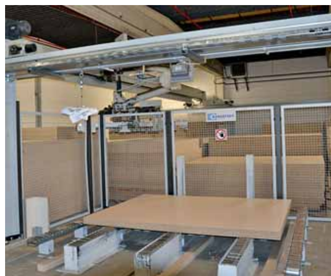
Das Plattenlager versorgt zwei Zuschnittsägen: eine Winkelanlage „HKL 380“ (heute: „Sawteq B-300“) und die „Sawteq B-320 Flextec“
