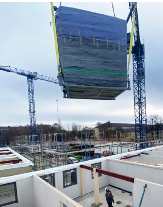
Im Holzfertigbau heben Kräne vorgefertigte Komponenten in Minuten an ihren Platz. Selbst komplette Badezimmer lassen sich so ins Gebäude einsetzen.
