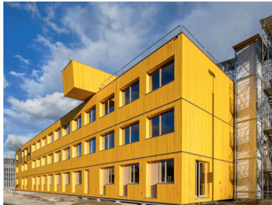
Holzmodulen bestehen. „Die kompletten Module fertigen wir individuell nach Wunsch der Kunden in unserem Werk“, sagt Lehmann. Mit digital gesteuerten Anlagen, welche die Elemente rasch und effizient produzieren.
