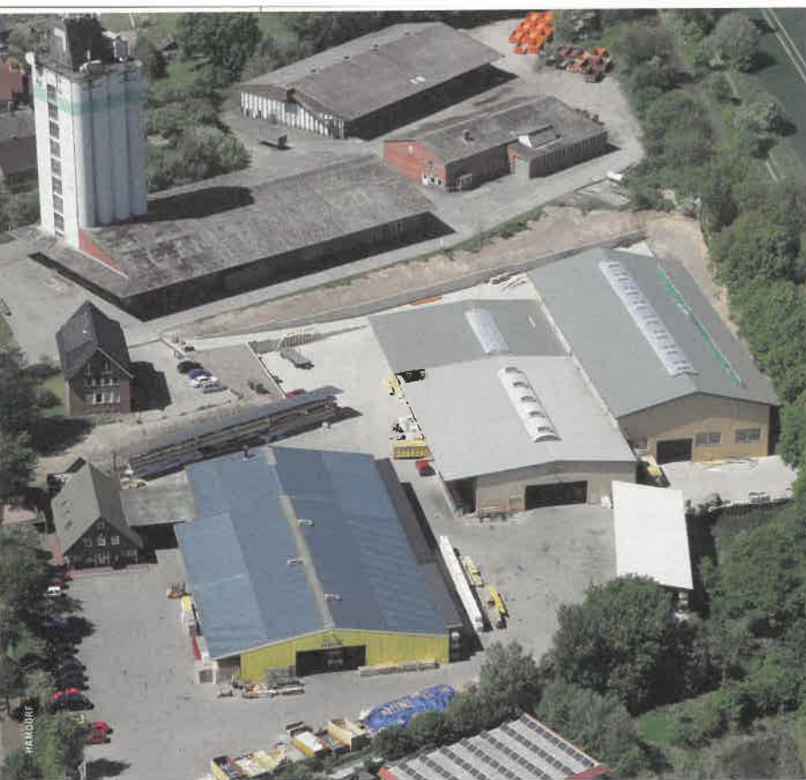
◀ Das Betriebsgelände der Zimmerei Hamdorf in Fahrenkrug: Ihr Schwerpunkt liegt im Objekt- und Gewerbebau und in der Fertigung von Holzrahmenelementen
