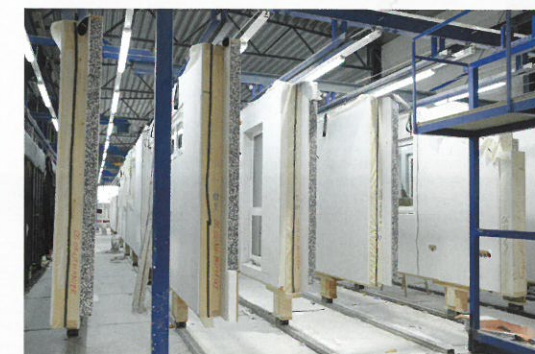
Im Puffer können Fenster-, Installationsmontagen und Verputzarbeiten am stehenden Element ausgeführt werden. Die sechs Spuren brauchen wenig Hallenfläche und gewährleisten ausreichende Trockenzeiten.
