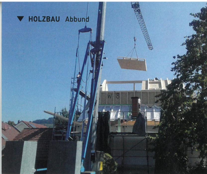
Immer öfter werden auch komplette Dachelemente vorgefertigt und montiert
