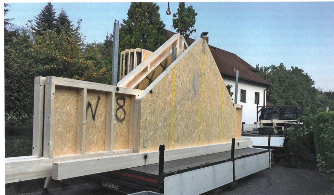
Vorgefertigte Holzrahmenelemente werden auf die Baustelle geliefert
