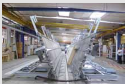
Sonderwandfertigung | Special wall production
