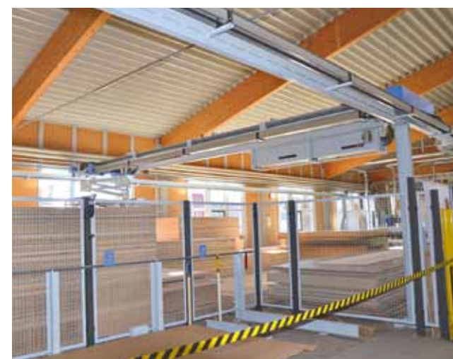
Das automatische Plattenlager TLF 211 kann alle Plattenmaße bis hin zum größten Standardformat 5 600 x 2 200 mm aufnehmen und verwalten.
