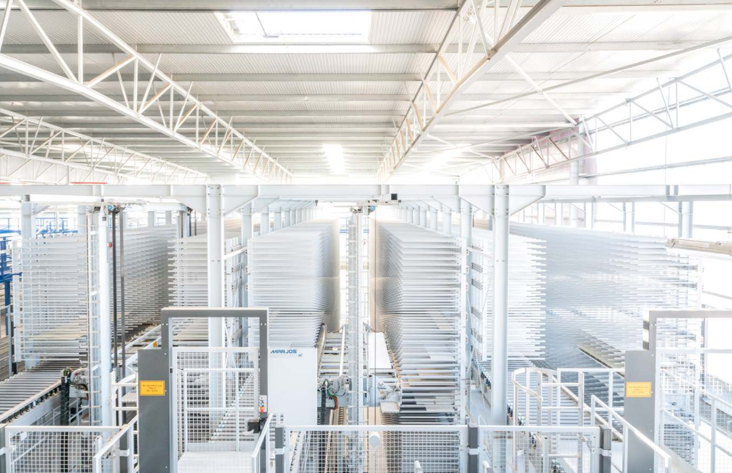
Unendliche Weiten: Der gigantische Sortierpuffer ist gleichzeitig ein Transportlift in die untere Etage der Fertigungslinie.
